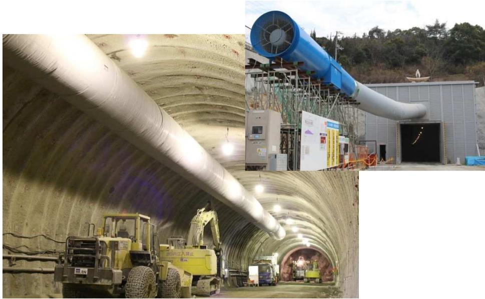
写真-1 導入現場の電気機器（工事照明、換気ファン）
